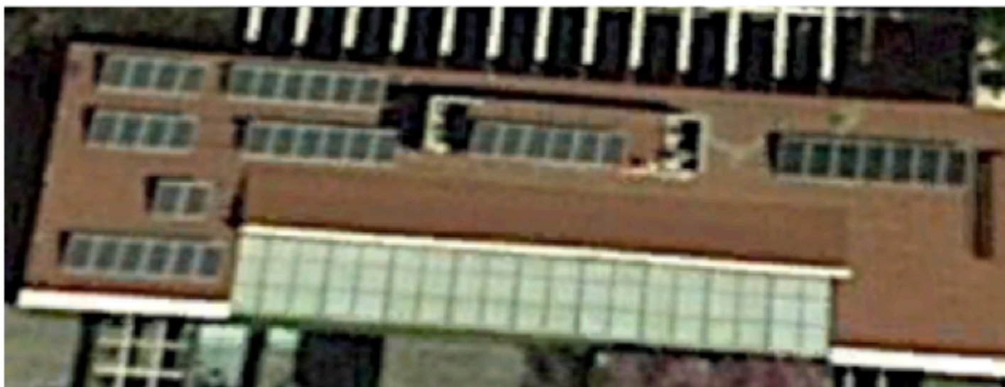
Las Aguilas, CDMX: 34 módulos, 8.65 KWp
