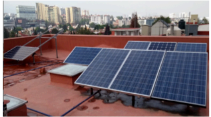
Huixquilucan, Edo. Mex: 3+ 4+1= 8 módulos, 2.2 KWp- P4028a
